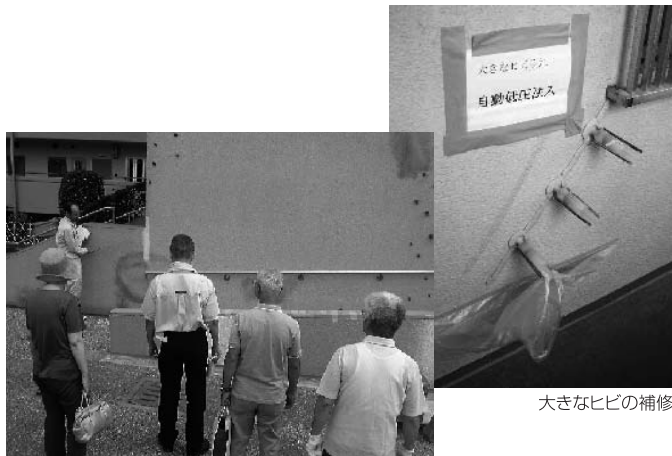
壁の補修の説明
