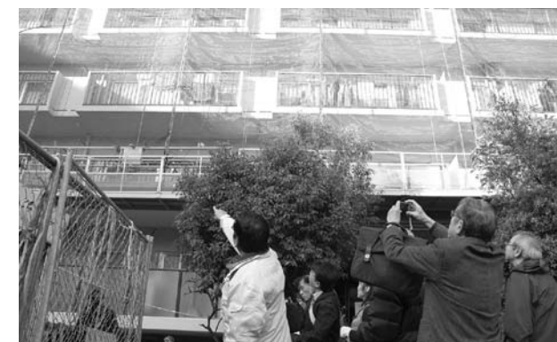
大規模修繕工事見学会
