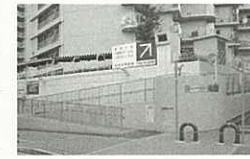
▲北口スロープの一部を緩やかな傾斜にして、バリアフリー化を実現
