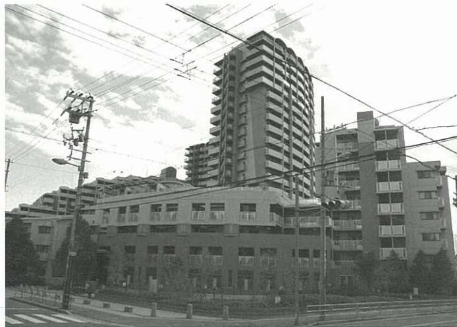
▲センター棟、イースト棟、ウエスト棟の3棟からなるベイシティ大阪の外観
