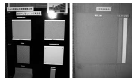
▲カラープランニング決定色として掲示 ▲外壁の一面に外壁塗装の色を具体的に掲示
